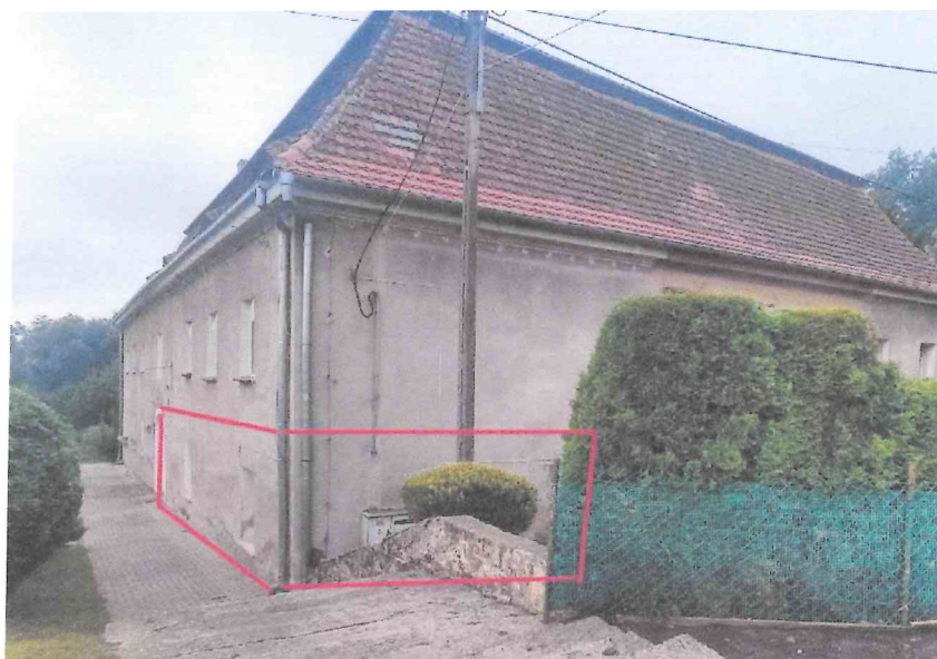
usytuowanie w budynku
